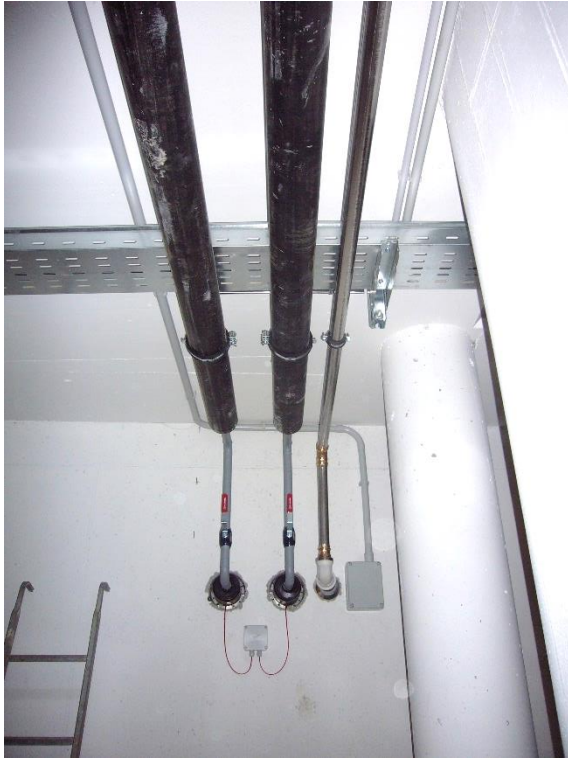
Beispiel Ummantelung Wasser- und Fernwärmerohre Verschiedene Ausführungsphasen
