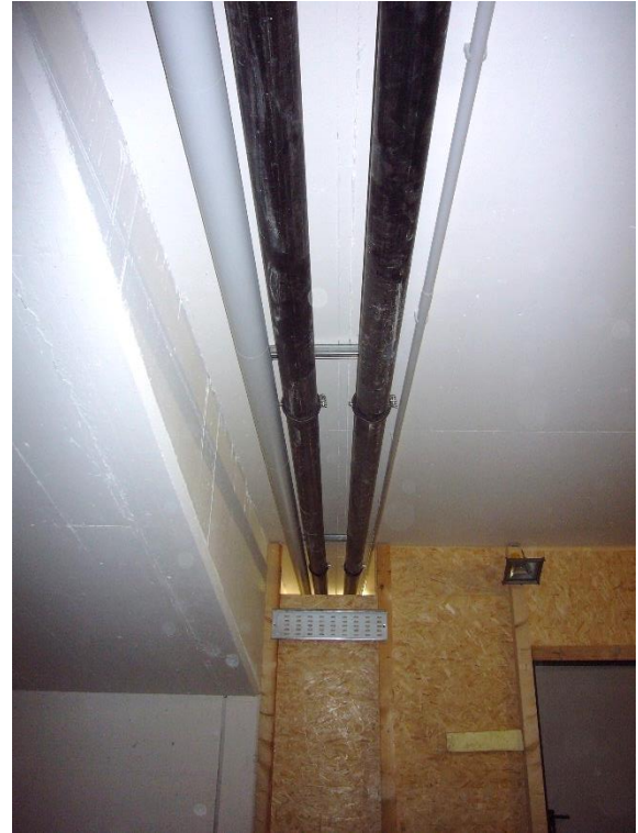
Esempio rivestimento tubazioni idriche e termiche Diverse fasi di lavoro
