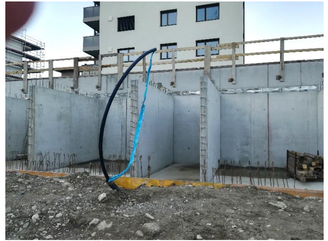
Esempio tubo di protezione sotto fondamenta
